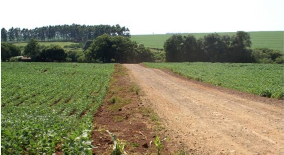
Figura 7.10 Construção e elevação do leito de estrada acima do nível da lavoura e terraceamento.
